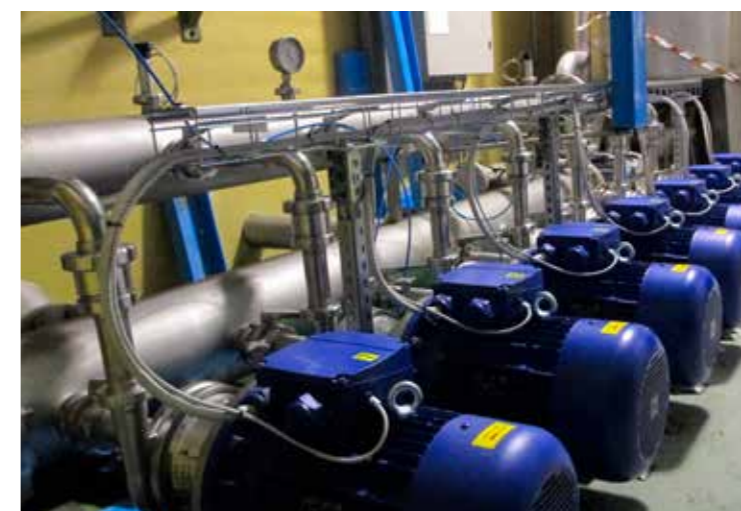
Quadri di comando e controllo e motori SuPremE in un impianto di pompaggio presso uno stabilimento di produzione di acqua minerale
