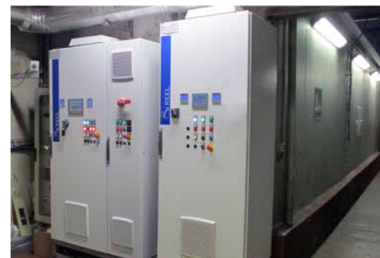
Quadri di comando e controllo circuito degasatore e impianto di pompaggio equipaggiato con motori SuPremE per il circuito raffreddamento glicole presso stabilimento Galbani
