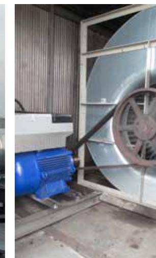
UTA equipaggiati di motori SuPremE e convertitori a bordo motore FlexiMova mm presso stabilimenti Coop Alleanza 3.0
