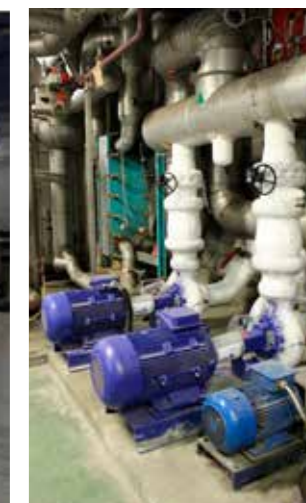
Quadri di comando e controllo circuito degasatore e impianto di pompaggio equipaggiato con motori SuPremE per il circuito raffreddamento glicole presso stabilimento Galbani
