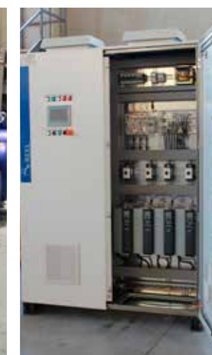
Quadri di comando e controllo e motori SuPremE in un impianto di pompaggio presso uno stabilimento di produzione di acqua minerale
