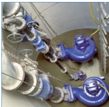
Fig. 2.12b : Guidage par câble
