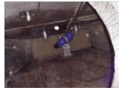
Fig. 5.7 : Mélangeur submersible installé dans une bache de pompage
