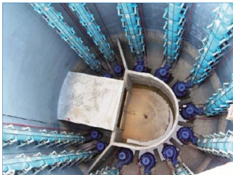
Fig. 5.11e : Ouvrage réalisé de la station de relevage KRT précédemment calculée
