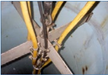
Fig. 3.3-d : Eléments de support pour le maintien en place du faisceau de câbles dans le tube
