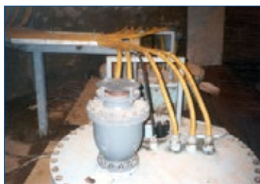
Fig. 3.2-c : Ventilation du tube par vanne d'aération et de purge d'air
