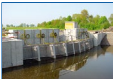
Fig. 2.7-a : Dégrilleur grossier en amont d'une station de relevage Amacan (captage d'eau de rivière)
