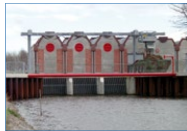
Fig. 2.7-i : Station de relevage avec dégrilleur automatique
