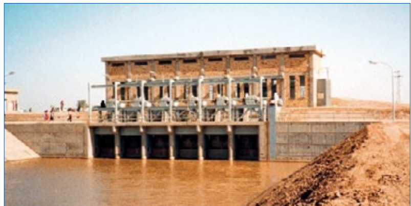
Fig. 10 : Station de relevage avec bâtiment
