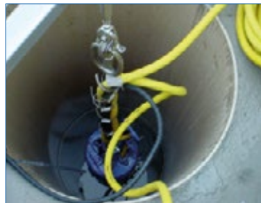
Fig. 3.3-e : Blocage de câble par de simples colliers de serrage
