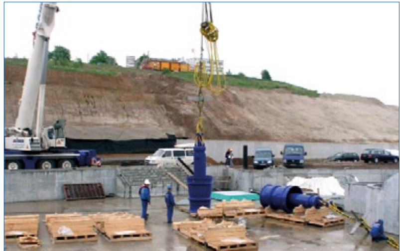
Fig. 9 : Pose d'une pompe submersible à l'aide d'une grue mobile
