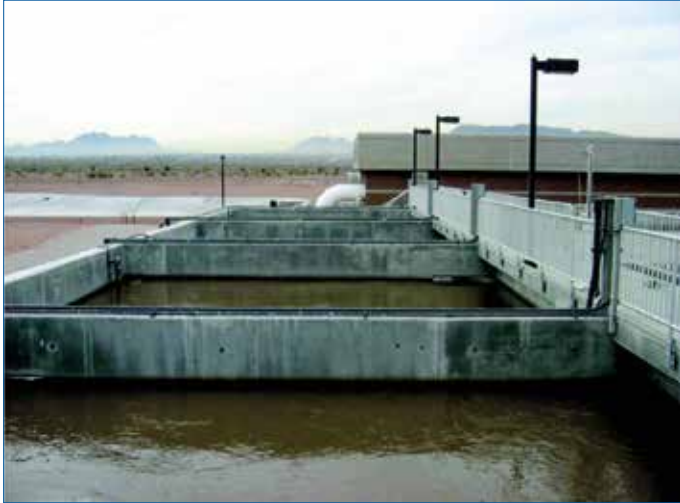
Abb. 12: Typisches Becken einer Abwasserbehandlungsanlage (Henderson, NV)
