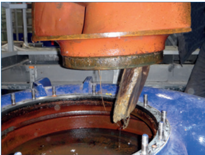
Abb. 91: Holz im Laufrad einer KRT-Pumpe
