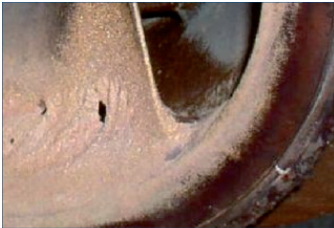
Abb. 5: Laufrad mit Kavitationsschäden (Quelle: KSB – Kreiselpumpenlexikon [01.06])
