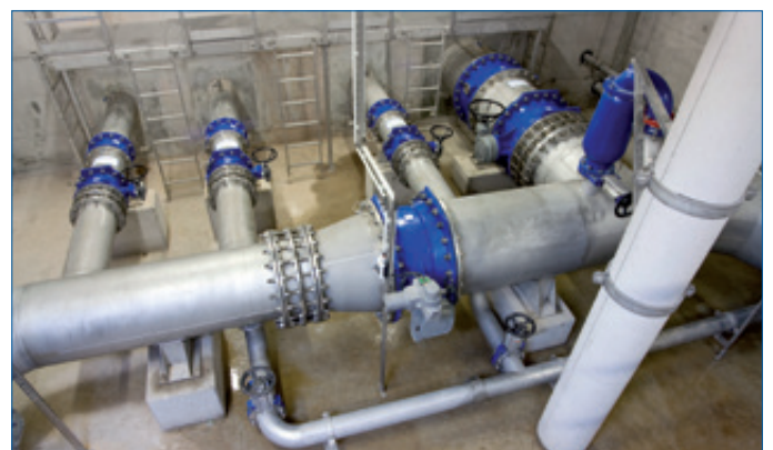
Abb. 55: Armaturenraum mit horizontaler Einbindung der Rohrleitung
