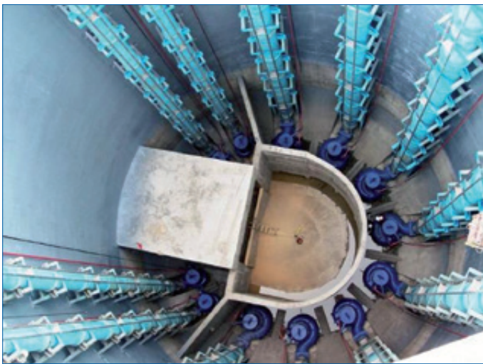
Abb. 113: Ausgeführtes Bauwerk der vorher berechneten KRT-Pumpstation
