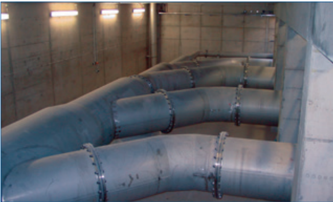
Abb. 57: Einbindung der Einzeldruckleitung in Fließbrichtung
