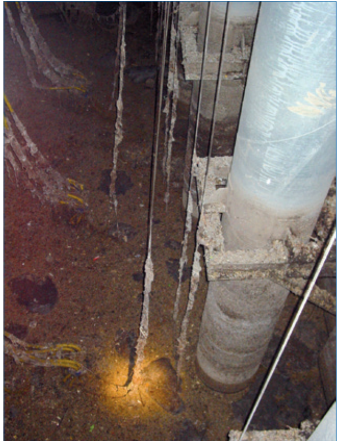
Abb. 92: Schwimmdeckenbildung im Pumpensämpf
