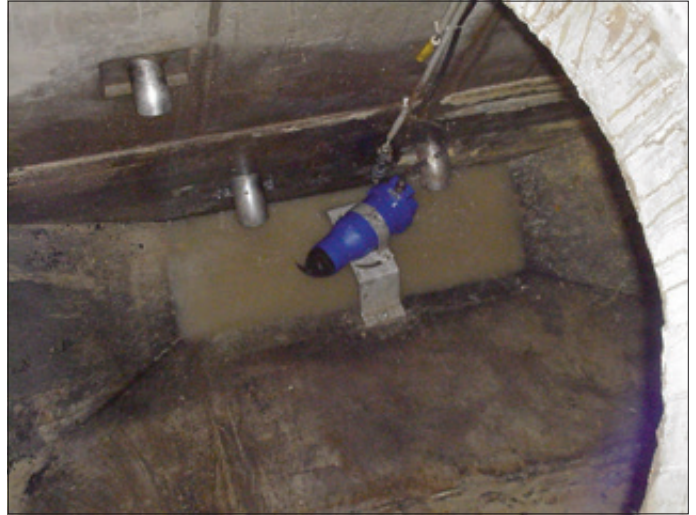
Abb. 103: Tauchmotormischer im Pumpensumpf
