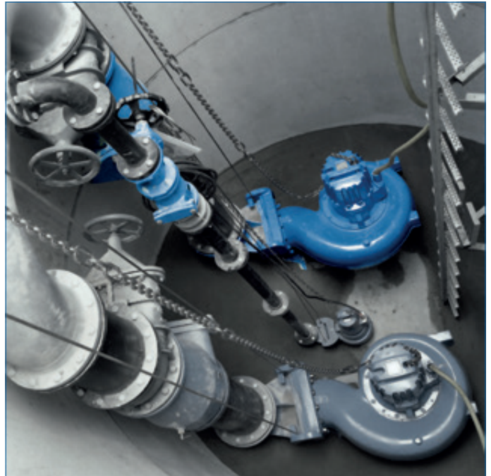
Abb. 53: Vertikale Anordnung der Armaturen im Pumpenschacht
