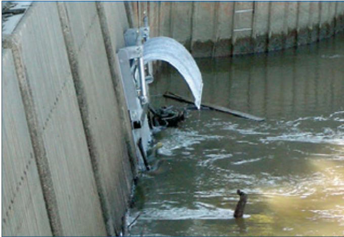
Abb. 85: Rechen mit automatischer Reinigung
